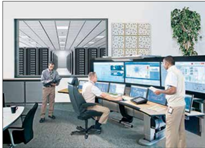
Figure 11 : Centre de gestion d'un data center – Source : Décathlon/ABB.
